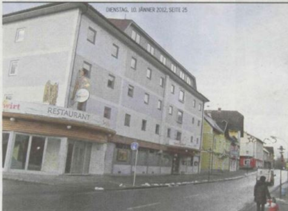
Das Hotel Seewirt ist bald Geschichte: Es wird voraussichtlich abgerissen und in eine Wohnanlage umgebaut
