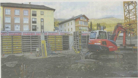
Im Zweischichtbetrieb – in Kärnten nicht alltäglich – wird auf der Baustelle in Millstatt gearbeitet. SOMMEREGGER-BAURECHT (2)
